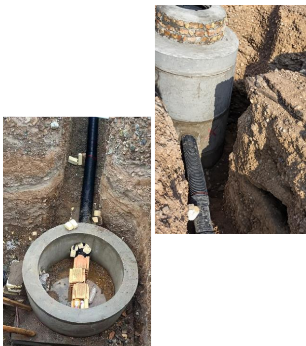
(۱۴) اجرای شبکه جمع آوری فاضلاب بلوک ۷ و ۸ خوابگاه
