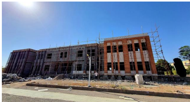
عملیات در دست اقدام: نماکاری ساختمان
