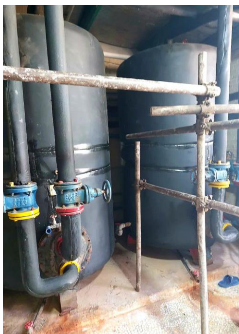
عایق‌کاری موتورخانه‌ها با نسل جدید عایق‌های الاستومری
