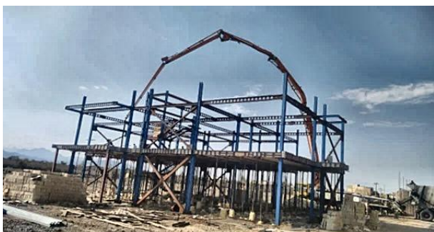
عملیات در دست اقدام: اجرای سقف تیرچه بلوک
