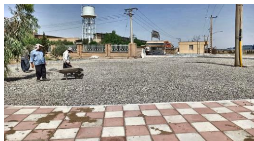
(۱۸) بهسازی و مناسب سازی محوطه و درب ورودی شماره ۶
