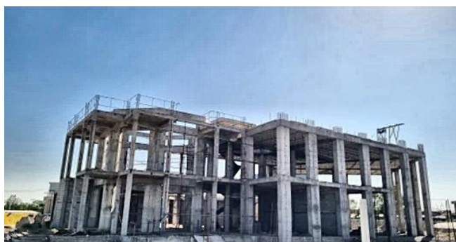
عملیات در دست اقدام: اجرای سازه گنبد ورودی
