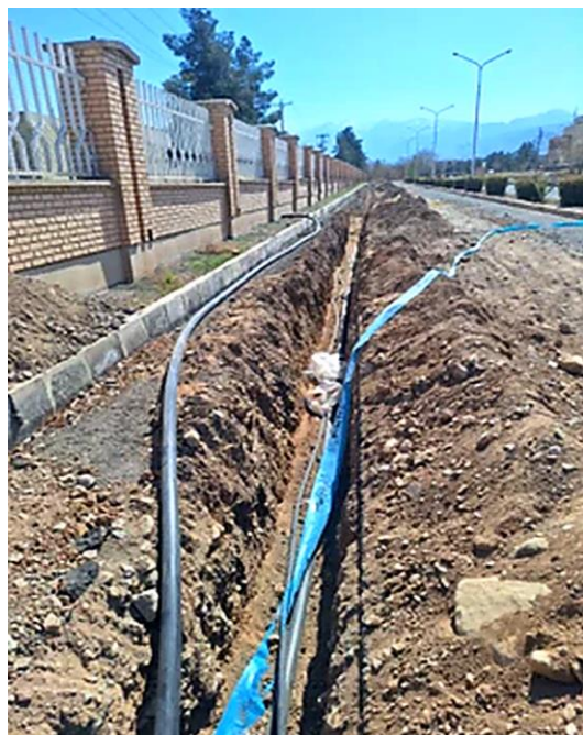
اصلاح و نوسازی شبکه آب مصرفی دانشگاه (۶ کیلومتر اصلاح شبکه، نصب کنتور هوشمند، نصب شیر هیدرانت)
