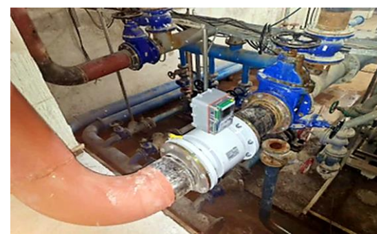
اصلاح و نوسازی شبکه آب مصرفی دانشگاه (۶ کیلومتر اصلاح شبکه، نصب کنتور هوشمند، نصب شیر هیدرانت)
