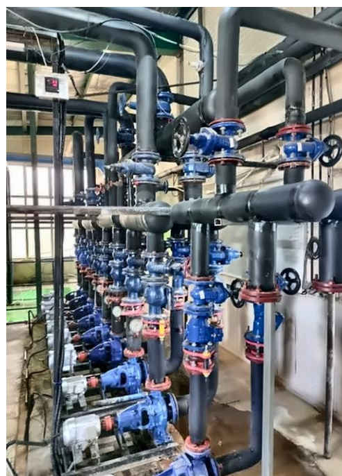
عایق‌کاری موتورخانه‌ها با نسل جدید عایق‌های الاستومری
