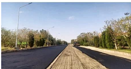
(۶) نوسازی و اصلاح آسفالت معابر (۴۶۰۰۰ متر مربع)
