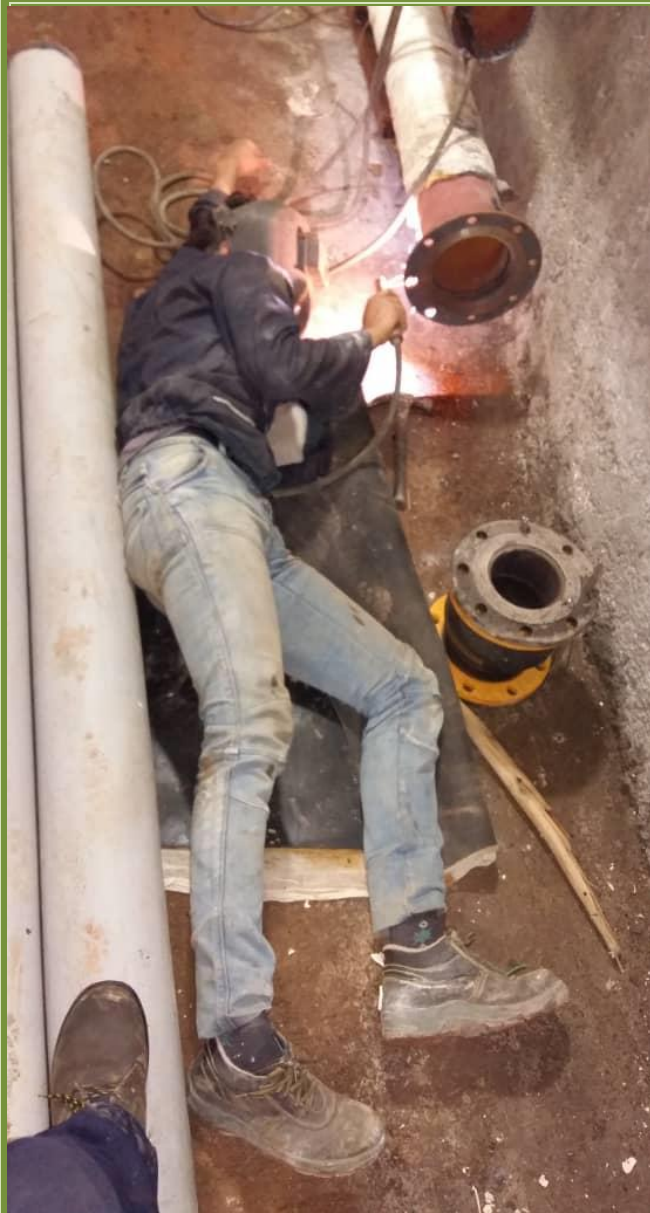
جوشکاری در کانال آدم رو
