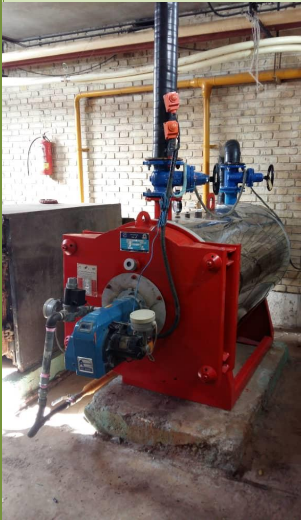
نصب دیگ در موتورخانه خوابگاه برادران
