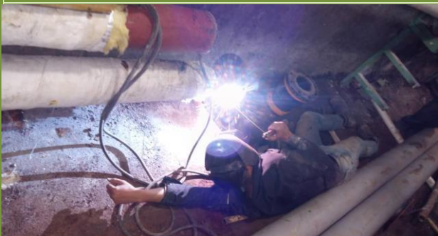
جوشکاری خطوط انتقال آب
