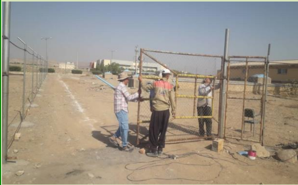
اجرای فنس اطراف تلمبه خانه و مخزن آب
