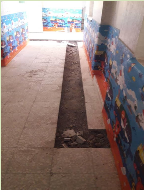
تعمیرات مهد کودک (لوله کشی سیستم گرمایش)
