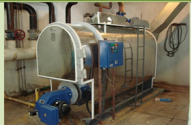
تعویض دیگ آب گرم موتورخانه مرکزی برادران
