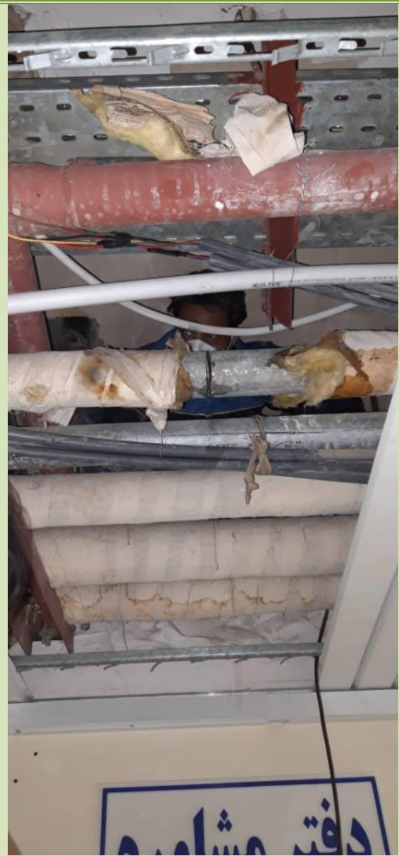
رفع نشتی لوله آب زیر سقف کاذب
