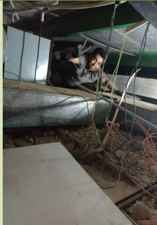
تعمیرات زیر سقف کاذب
