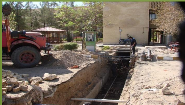
تعویض خط اصلی لوله سیستم شوفاژ بلوک ۷ و ساخت کانال آدم رو
