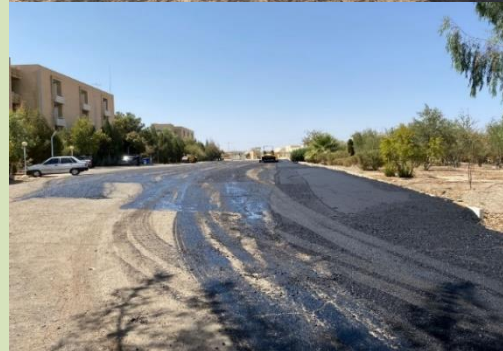
آسفالت محوطه خوابگاه دانشجویی حدود ۴۰۰۰ متر مربع
