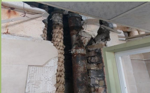
تعویض لوله های چدنی فاضلاب خوابگاه
