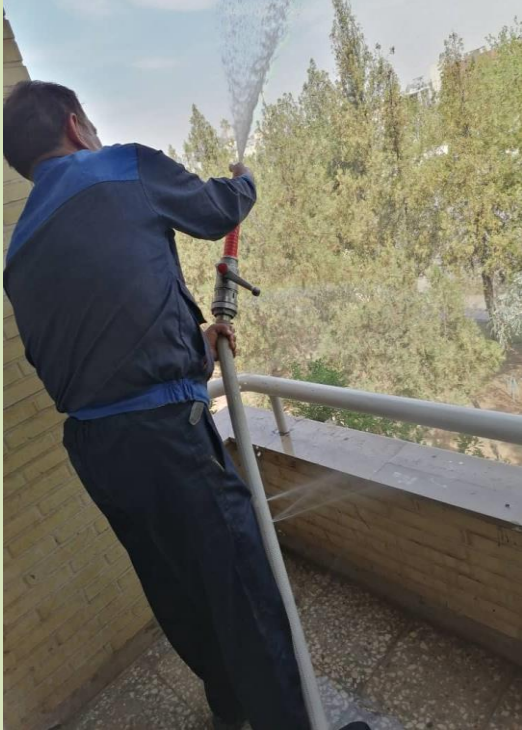
تست شیلنگ های آتش نشانی
