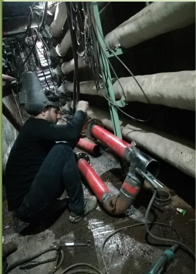
جوشکار خطوط انتقال آب در کانال آدم رو دانشکده علوم
