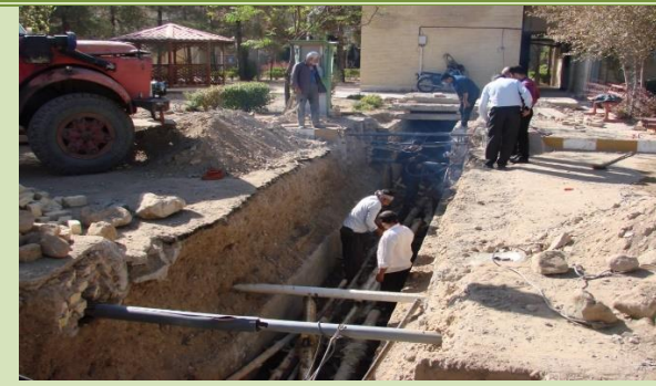
تعویض خط اصلی لوله سیستم شوفاژ بلوک ۷ و ساخت کانال آدم رو
