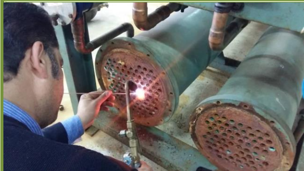
جوشکاری لوله های مسی کندانسور چیلر
