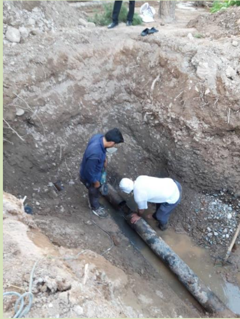
خاکبرداری و ترمیم ترکیدگی لوله چدن داکتیل
