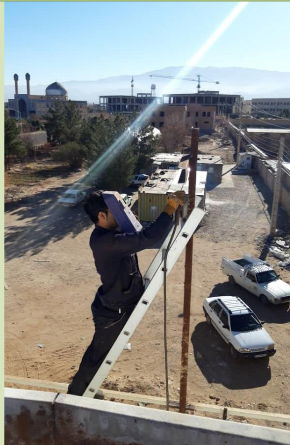
جوشکاری در برج دانشکده مهندسی جهت نصب پرژکتور
